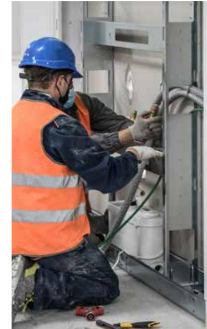
GEWISS si fa carico della parte di montaggio più complessa e dispendiosa, ovvero l'assemblaggio della carpenteria, la distribuzione delle barre, l'installazione e l'allacciamento degli interruttori aperti e, se richiesto, il montaggio e la connessione degli interruttori scatolati.
